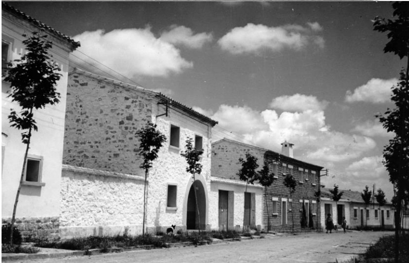
Instituto Nacional de Colonización Vistas de las viviendas de Bardena del Caudillo, El Temple, Valfonda de Santa Ana y Valsalada, décadas de 1940 y 1950 MINISTERIO DE AGRICULTURA, PESCA Y ALIMENTACIÓN. Archivo Central, Fondo Instituto Nacional de Colonización Archivo Histórico Provincial de Zaragoza, El Temple, MF COYNE 004800
