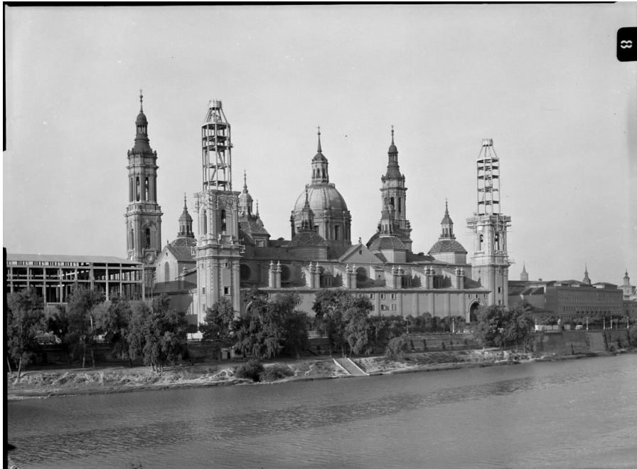
Estudio Coyne (Fotógrafo. Manuel Coyne Buil, Zaragoza, 1900 – 1994) Obras de construcción de las torres de la Basílica del Pilar, ca. 1954 Archivo Histórico Provincial de Zaragoza, MF Coyne 003898
