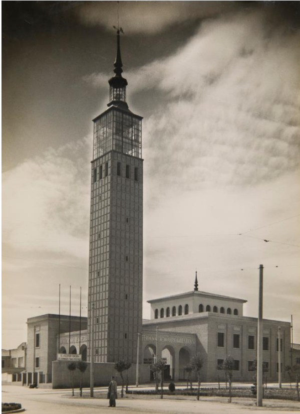
Regino Borobio Ojeda (Zaragoza, 1895 – 1976), José Borobio Ojeda (Zaragoza, 1907 – 1984) y José Beltrán Navarro (Elche, 1902 – Zaragoza, 1974) Ediciones Arribas Vista de la sede de la Feria de Muestras, ca. 1944 Archivo BAU
